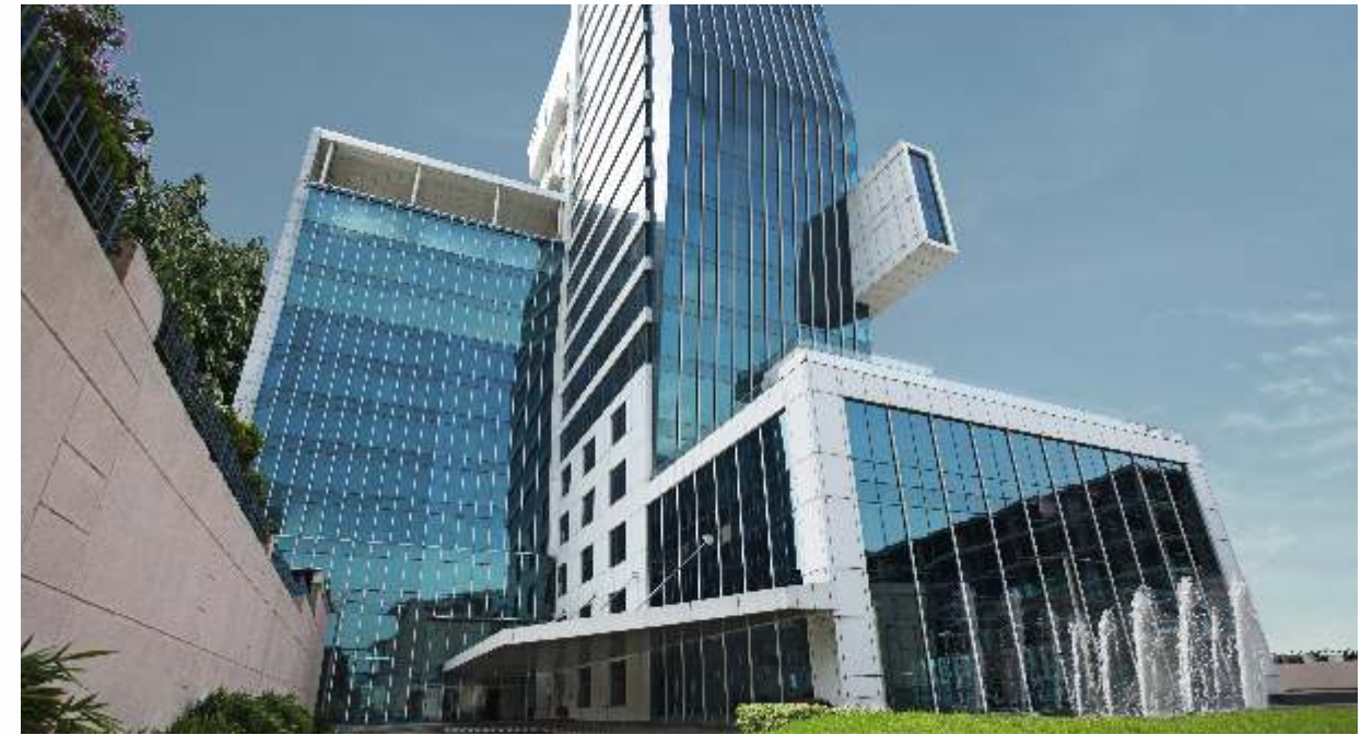
ACTUAL PHOTO OF FLOREAL TOWERS
